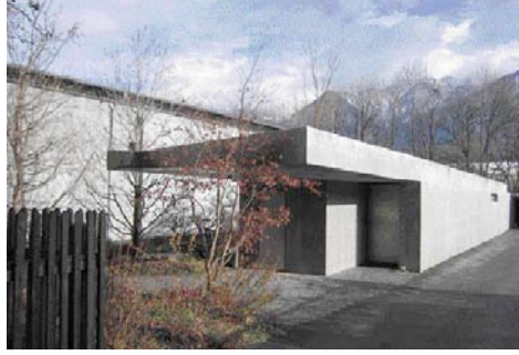
Woning Haldenstein. Peter Zumthor
